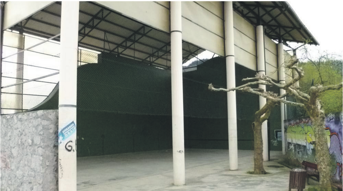
Arakaldoko frontoian instalatu nahi dituzte plaka fotovoltaikoak. Aiaraldea.eus
