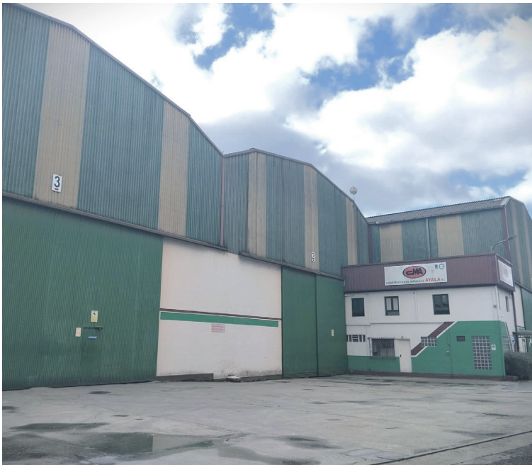
Construcciones Metálicas Ayala enpresaren lantegia. Aiaraldea.eus
