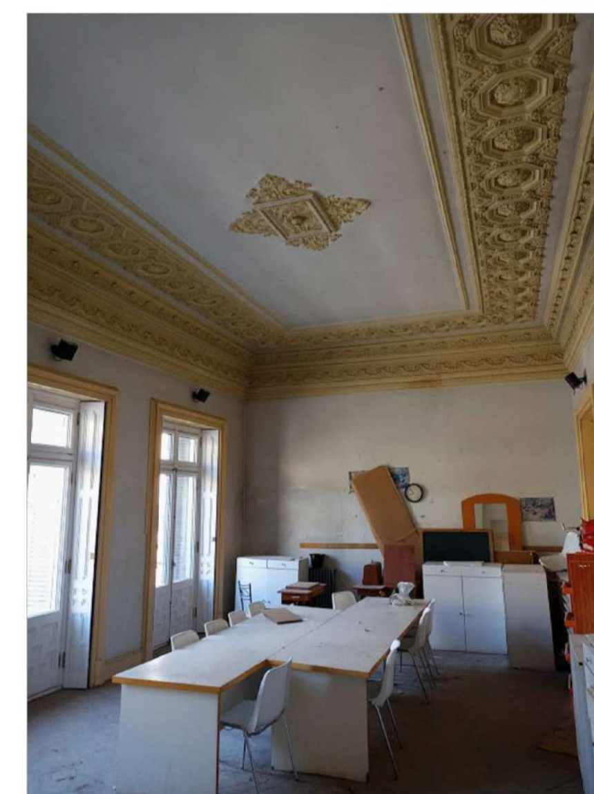
ALA NORTE. RESTAURACIÓN INTERIOR. SALÓN PRINCIPAL
