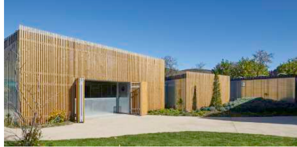
Centro de eventos la arboleda del Sur - Picado De Blas Arquitectos _ Argazkilaritza / Fotografia: Eugeni Pons
