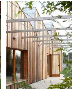
Aula de naturaleza Franqueses del Vallés, Edra Arquitectura Km0 y Bunyesc arquitectes _ Arg / Fot: Stella Rotger
